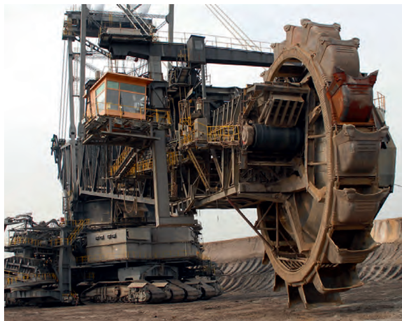
Schaufelradbagger im Tagebau Welzow-Süd (Foto: C. Nicolai)
