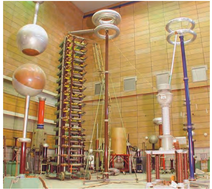
Stoßspannungsprüfungen an einem Messwandler
