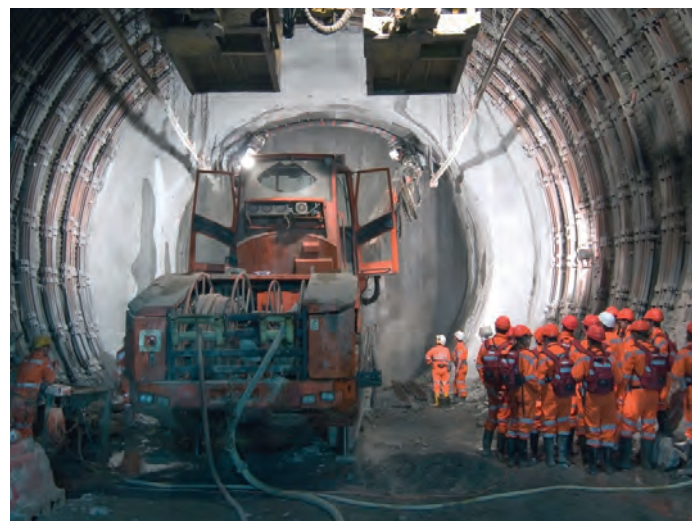
Vortrieb im Gotthard-Basistunnel (Foto: U. Glaubach)
