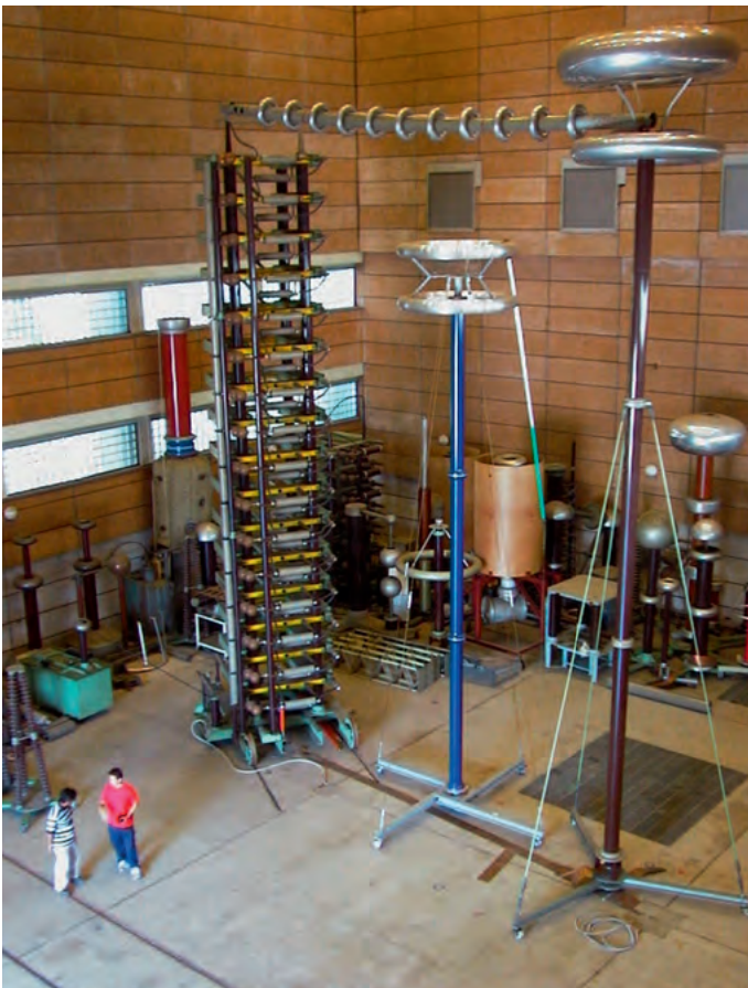
3,2-Millionen-Volt-Stoßspannungsgenerator in der Großen Hochspannungshalle
