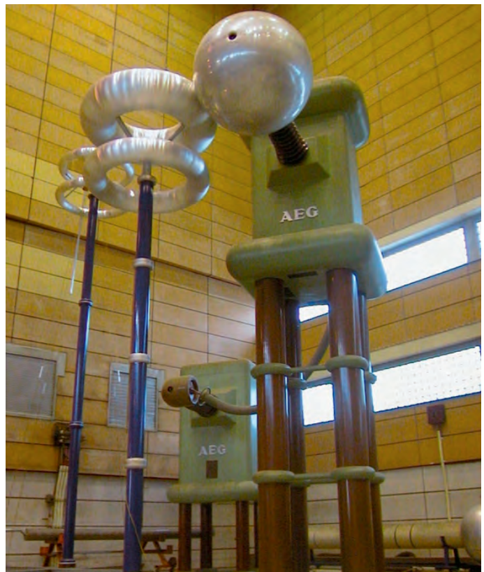
1,2-Millionen-Volt Wechselspannungstransformatorkaskade in der Großen Hochspannungshalle
