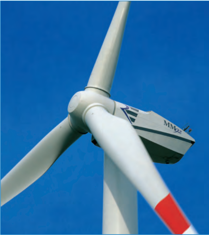
Rotorblätter einer Windkraftanlage aus faserverstärkten Kunststoffen. Grundlagenuntersuchungen zum Versagensverhalten der Kunststoff-Verbunde haben für die Auslegung und den Bau der bis zu 60 m langen und 18 t schweren Rotorblätter eine entscheidende Bedeutung. (REpower)
