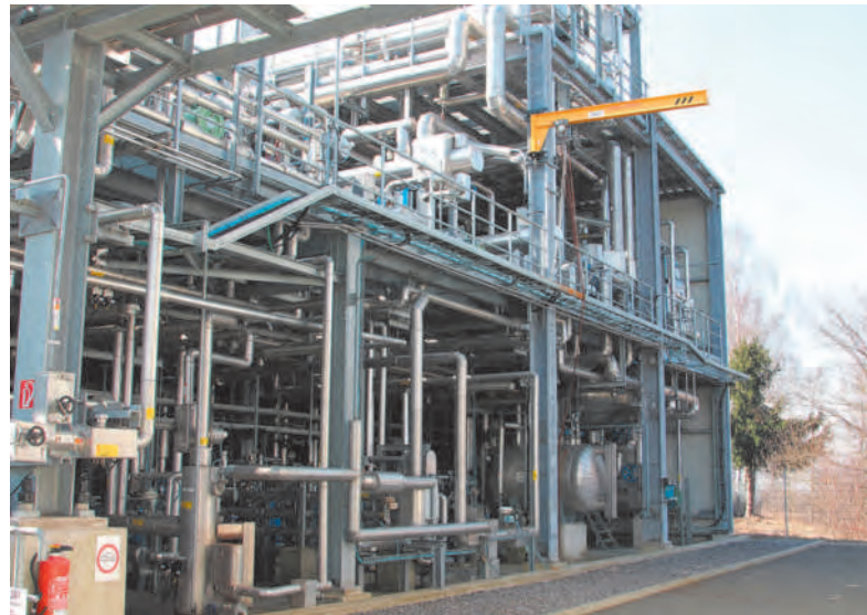
STF-Versuchsanlage zur Herstellung von synthetischem Benzin
