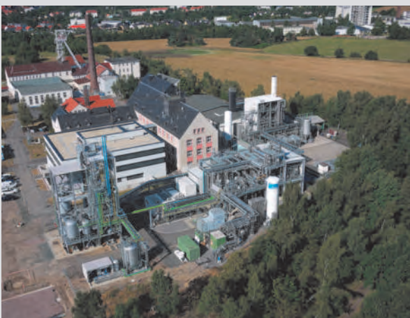
Institut für Energieverfahrenstechnik und Chemieingenieurwesen (im Vordergrund) in Nachbarschaft zum Lehr- und Forschungsbergwerk „Reiche Zeche“ (im Hintergrund)
