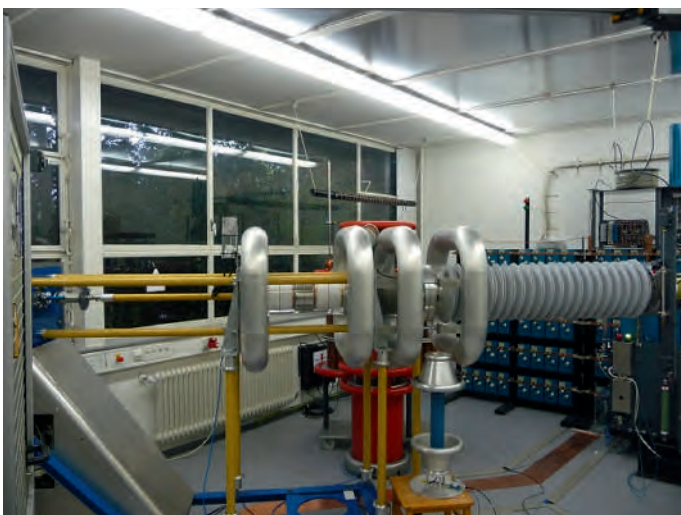
Blick in das Prüflabor zur Untersuchung von 72,5-kV Vakuumschaltern
