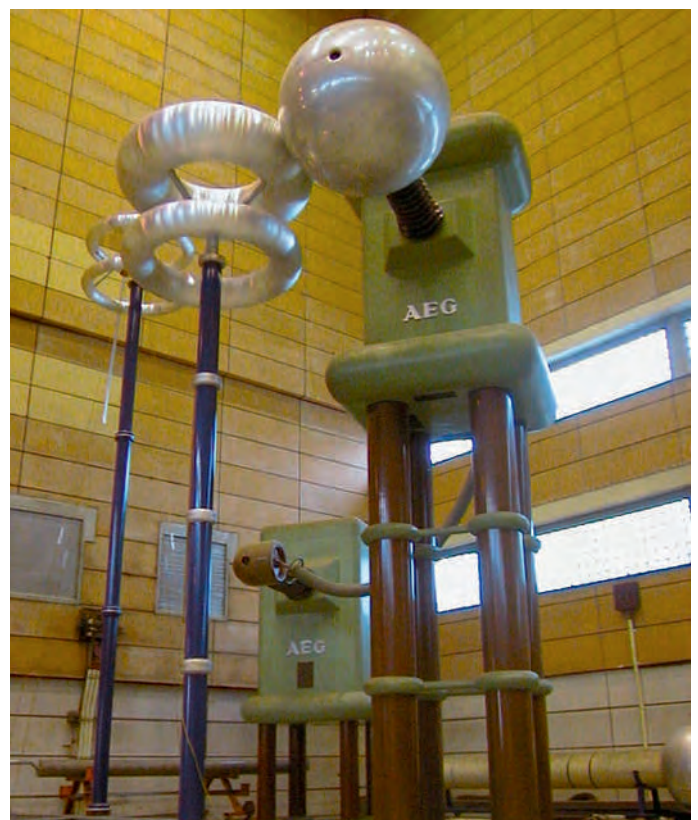
1,2-Millionen-Volt Wechselspannungstransformatorkaskade in der Großen Hochspannungshalle
