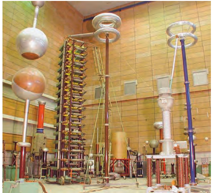
Stoßspannungsprüfungen an einem Messwandler
