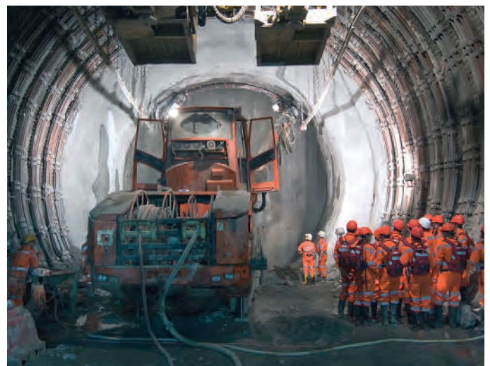
Vortrieb im Gotthard-Basistunnel (Foto: U. Glaubach)
