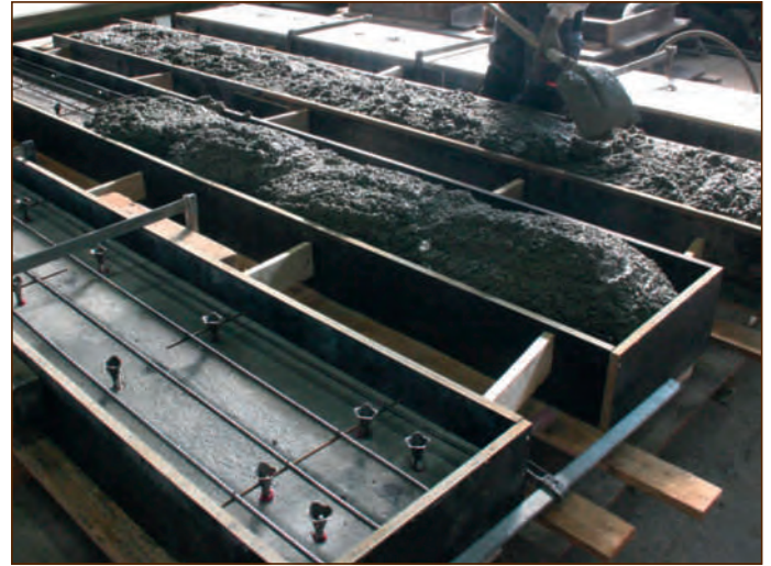
Abb. 10: Betonierung der Betonträger für die Forschungsversuche in der eigenen Betonwerkstatt, Foto: Detlef Podehl
