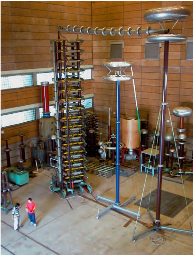
3,2-Millionen-Volt-Stoßspannungsgenerator in der Großen Hochspannungshalle
